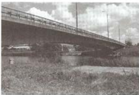
1 | Gesamtansicht der „Vorpommernbrücke“ in Rostock
